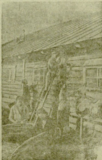
Подготовка теплой зимовки для скота. На снимке: животноводческая бригада колхоза имени 8 марта (Кохомский район, Ивановская область) заканчивает ремонт скотного двора.
